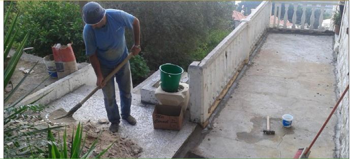
Die Wasserschäden im Erdgeschoß des Internats von Bischof Melki in Harissa konnten behoben und damit die durch Feuchtigkeit im Winter beeinträchtigte Wohnsituation für die Kinder deutlich verbessert werden.
